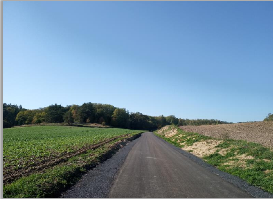
Fot. 13. Droga w miejscowości Gostyń po przebudowie
