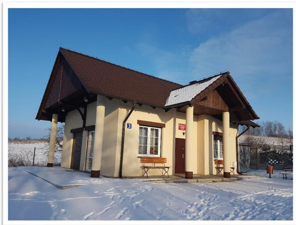
Fot. 39. Budynek gminny w Śremie
