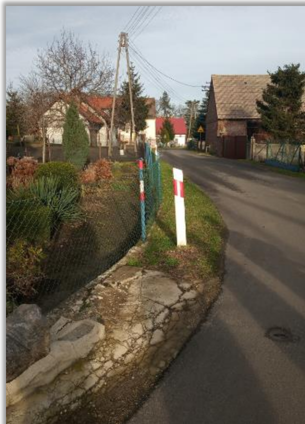
Fot. 35. Droga gminna w Dalkowie przed ułożeniem korytek ściekowych
