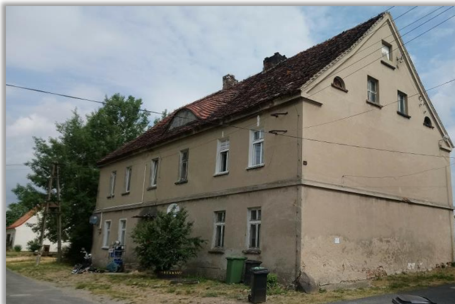
Fot. 20. Budynek mieszkalny przed modernizacją dachu – Dzików 16
