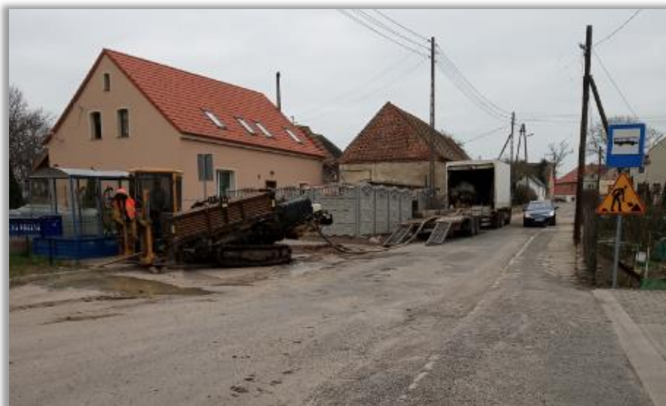
Fot. 14. Chodnik i droga przed wykonaniem inwestycji w Wierchowicach
