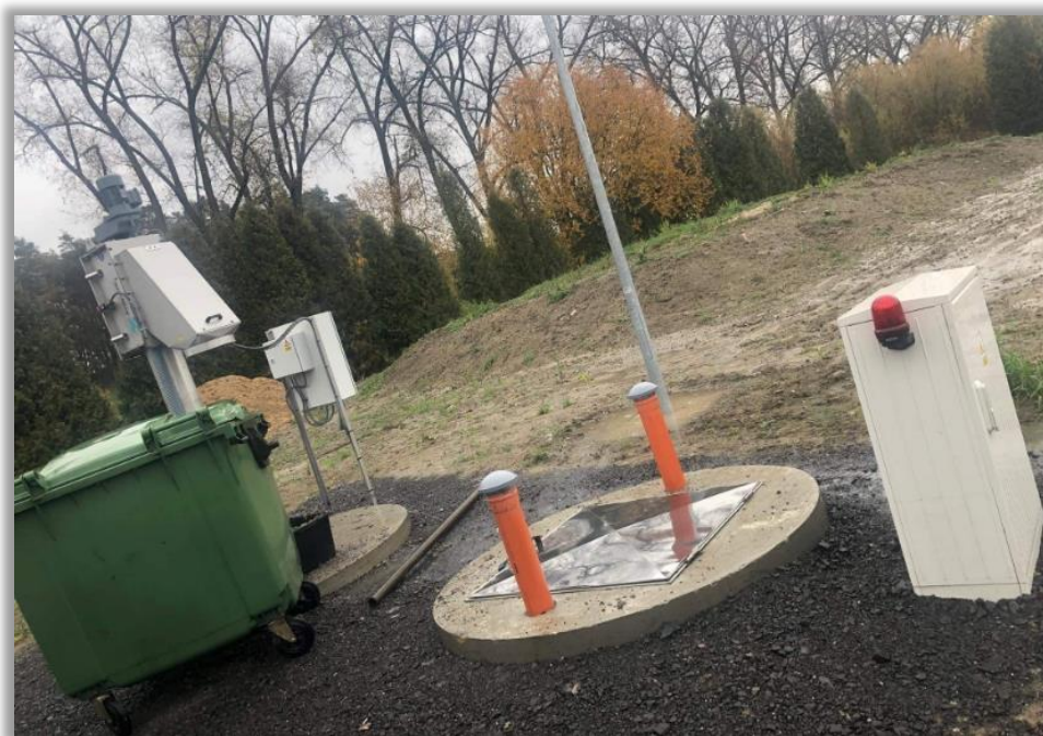
Fot.16. Sito pionowe i przepompownia ścieków na terenie oczyszczalni ścieków w Wierchowicach
