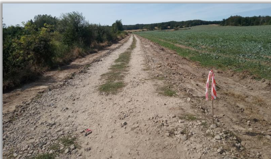
Fot. 4. Droga w Dalkowie przed przebudową
