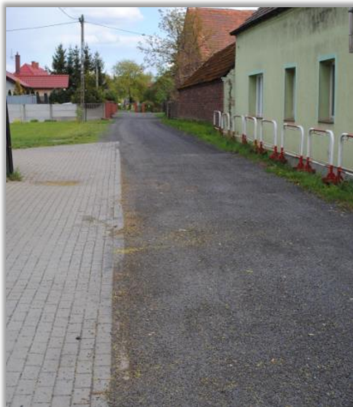
Fot. 19. Droga w Kłobuczynie po realizacji inwestycji
