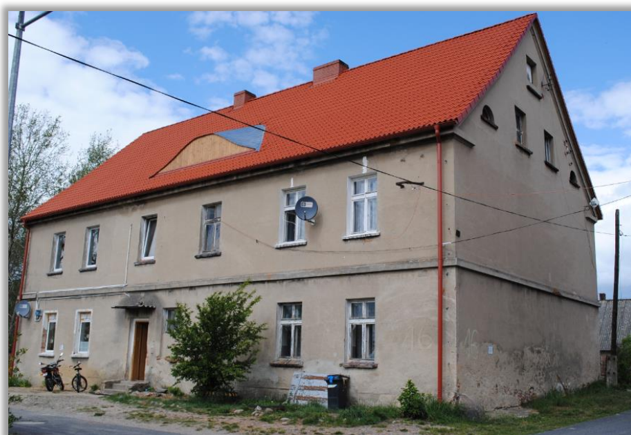
Fot. 21. Budynek mieszkalny po modernizacji dachu – Dzików 16
