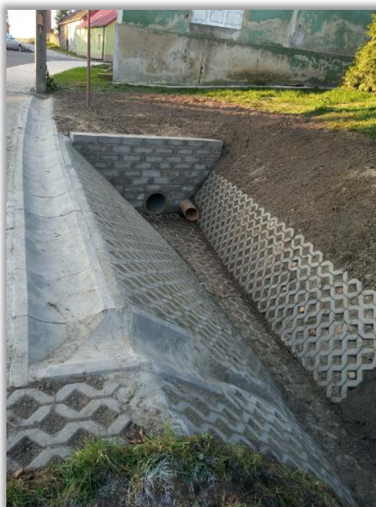
Fot. 37. Rów melioracyjny w Wierzchowicach po wykonaniu konserwacji
