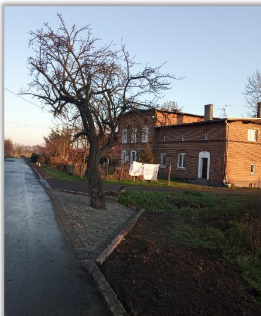
Fot. 36. Droga gminna w Dalkowie po ułożeniu krawężników
