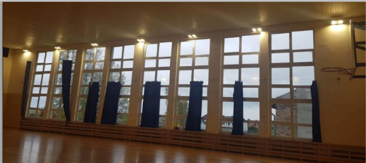
Fot. 34. Oświetlenie hali przy Szkole Podstawowej w Gaworzycach
