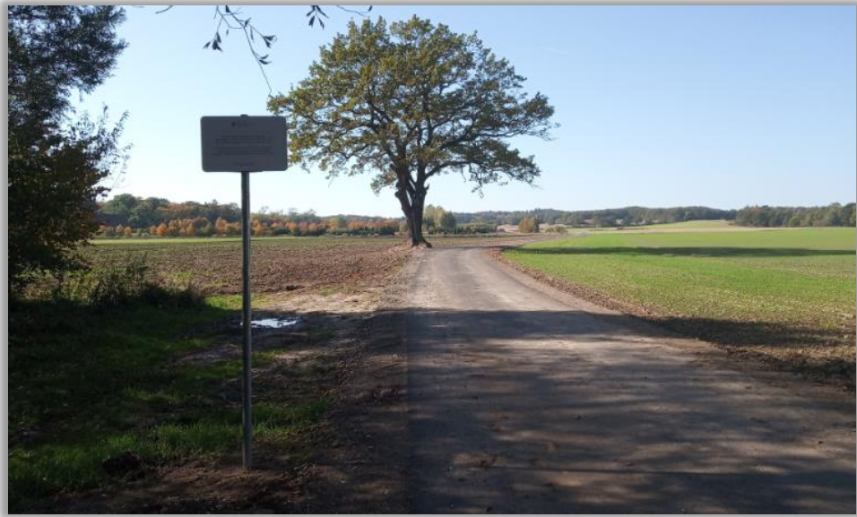
Fot. 5. Droga w Dalkowie po przebudowie
