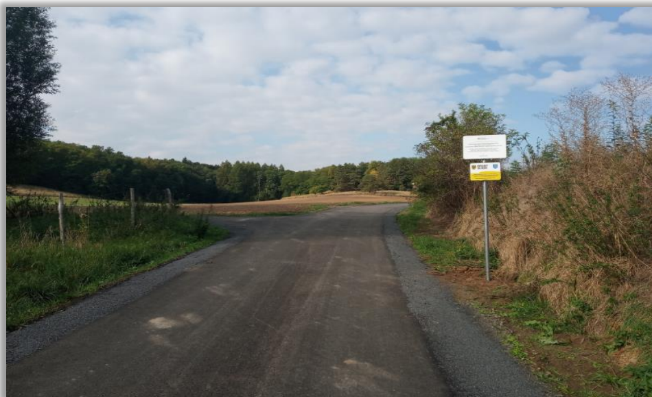
Fot. 12. Droga w miejscowości Gostyń po przebudowie
