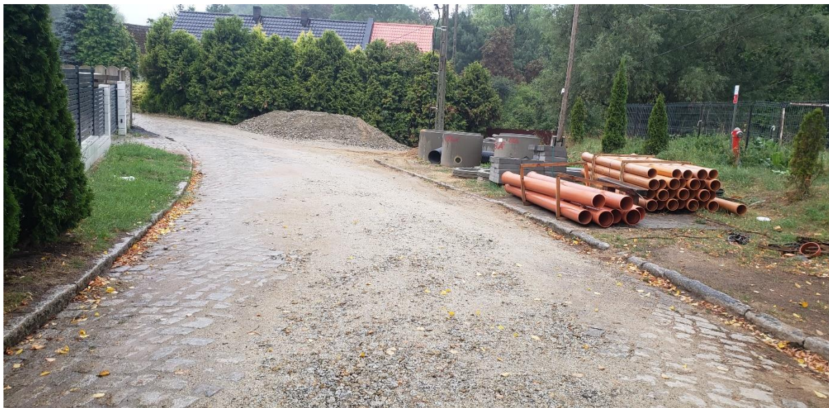
Fot. Przygotowanie do inwestycji – Śrem.
