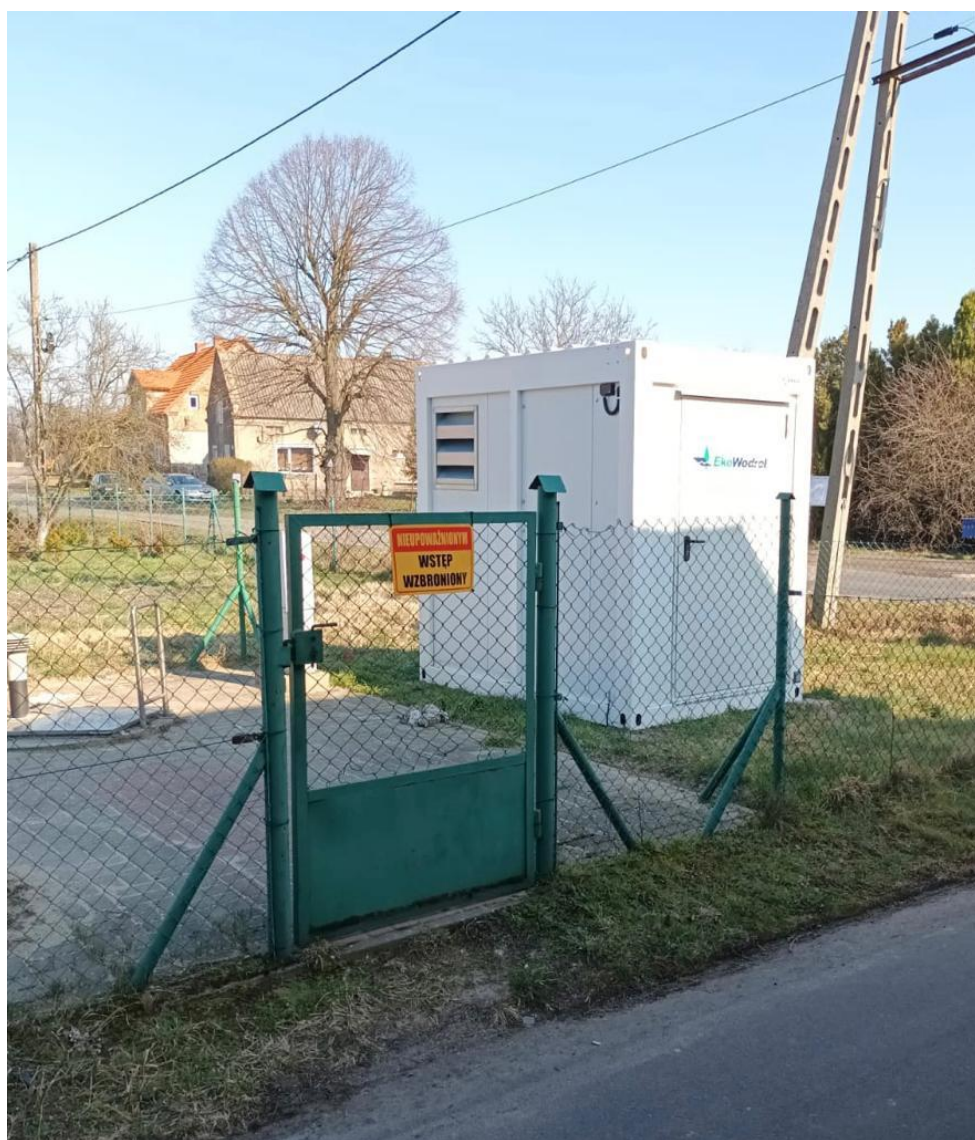
Fot. System płukania i napowietrzania rurociągu tłoczego przy przepompowni ścieków w miejscowości Kłobuczyn.
