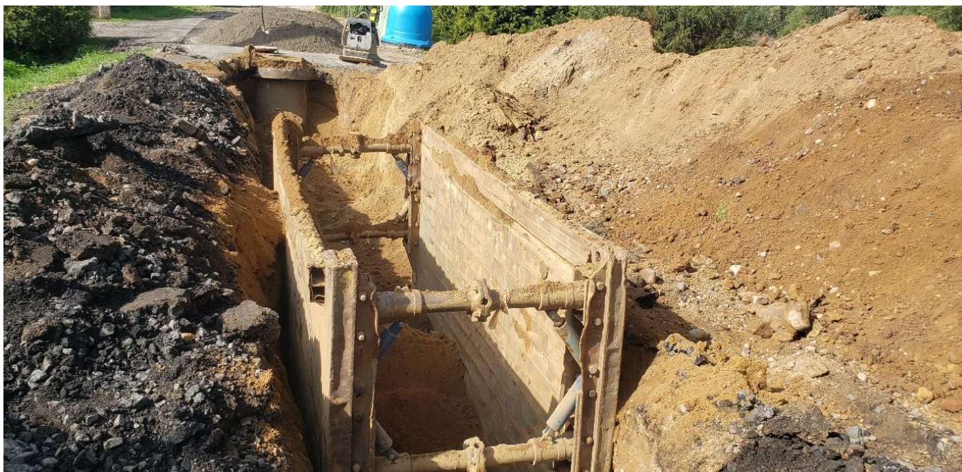
Fot. Układanie kanalizacji.
