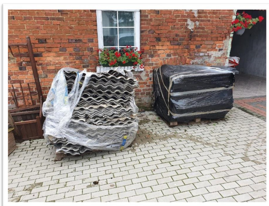
Fot. Przygotowane do odbioru płyty cementowo-azbestowe
