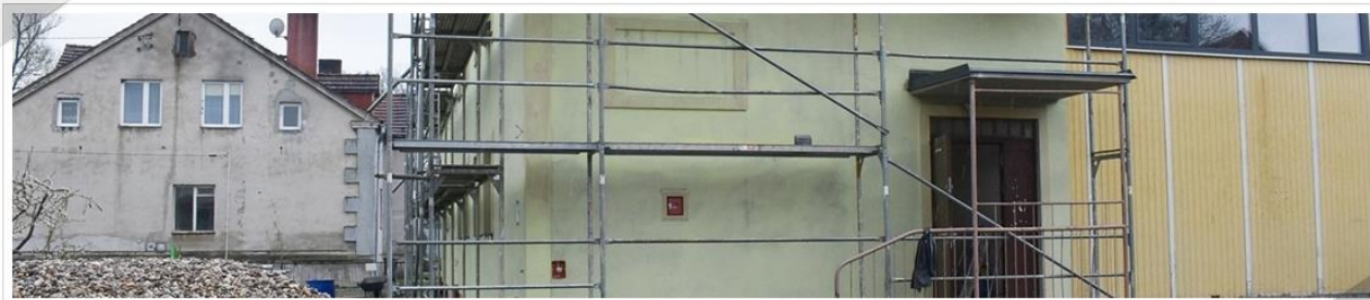
Fot. Sala Gimnastyczna w Dalkowie w trakcie prac remontowych.
