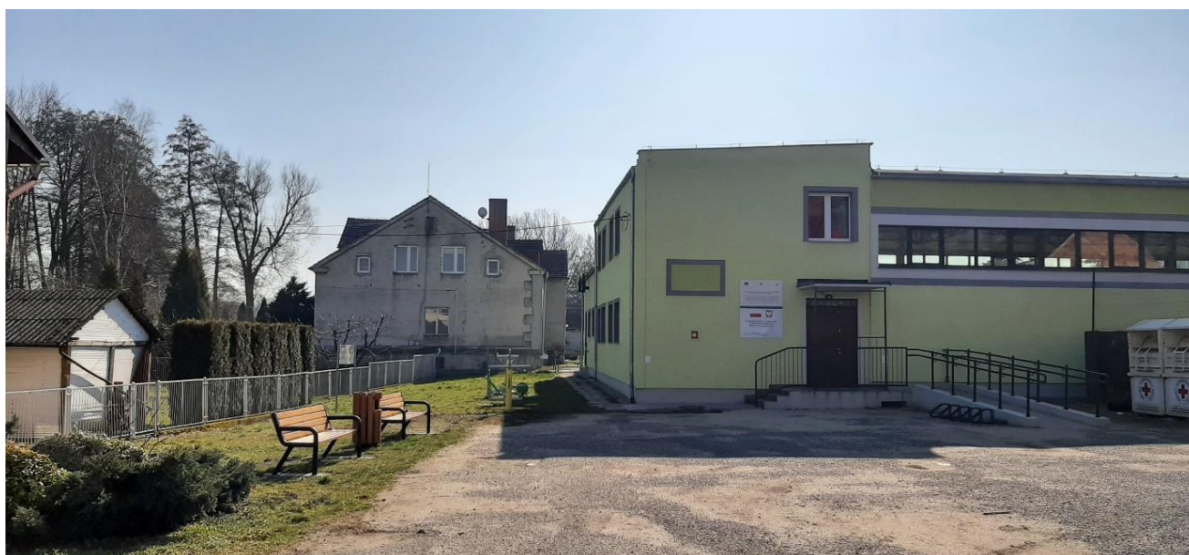
Fot. Sala w Dalkowie – elewacja frontowa.
