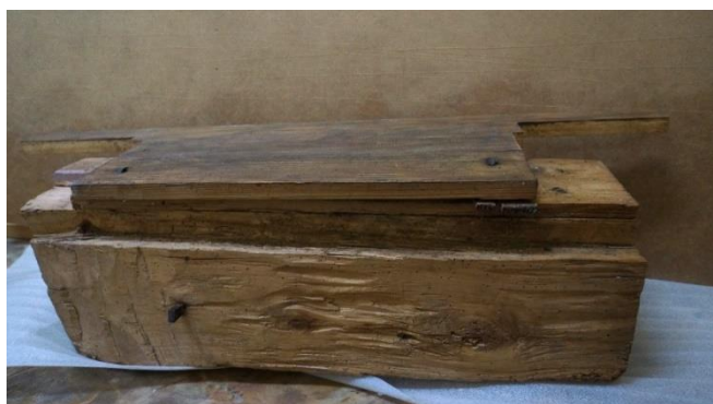
Fot. Ostatni stopień schodów po konserwacji Kościoła w Kurowie oraz podniebie schodów po konserwacji
