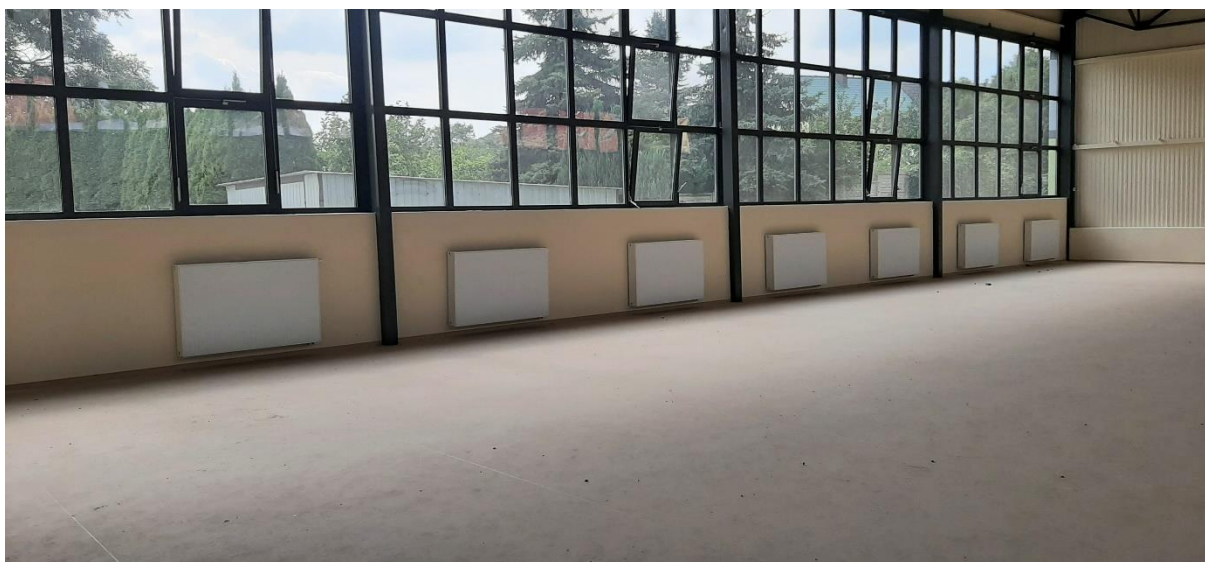
Fot. Sala Gimnastyczna w Dalkowie – nawierzchnia sportowa.
