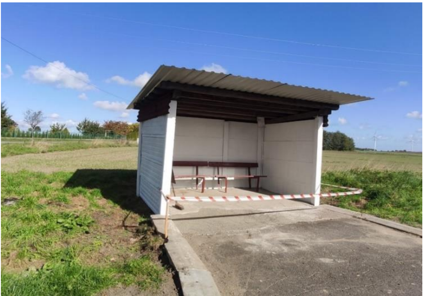
Fot. Remont przystanku autobusowego w miejscowości Grabik
